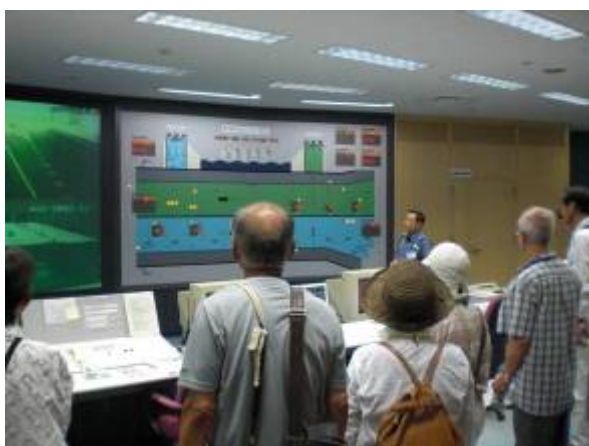
トンネル管制室
