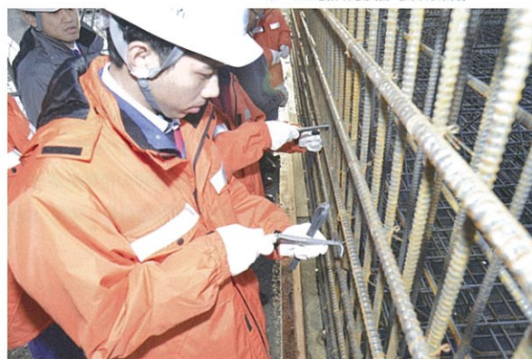
ケーソン製作体験実習（鉄筋結束作業）
