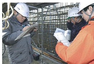
ケーソン製作体験実習（鉄筋組立状況確認）
