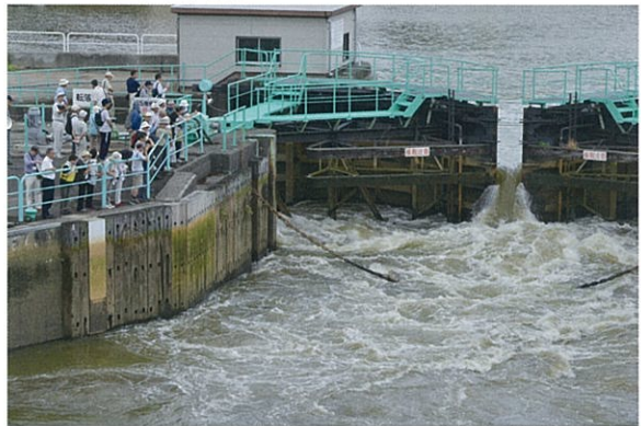
第4回/ゲートを開けて水位調節をする山の下閘門
