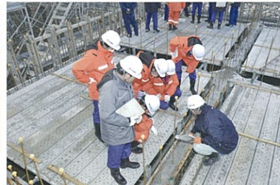
ケーソン製作体験実習（出来形確認）
