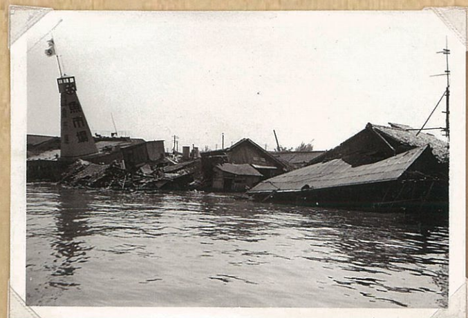
陥没した信濃川西護岸。
