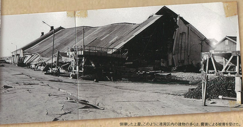
倒壊した上屋。このように港湾区内の建物の多くは、震害による被害を受けた。
