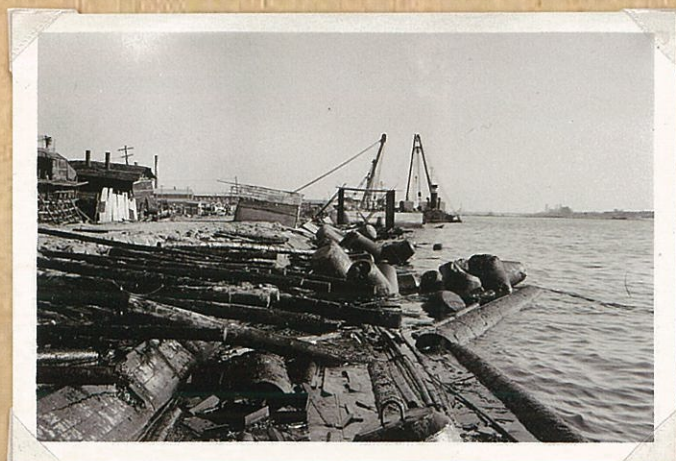
陥没した護岸に津波で流出した木材がうちあげられている。
