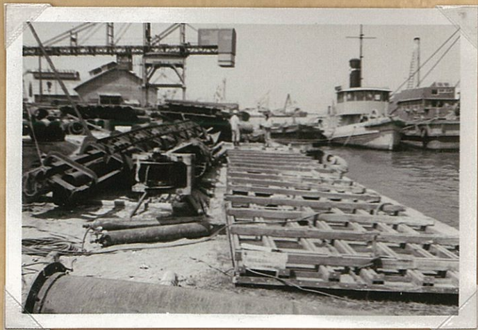
新潟港工事事務所構内の材料置場陥没。
