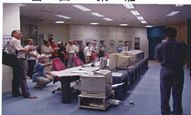
入船タワー内管制室
