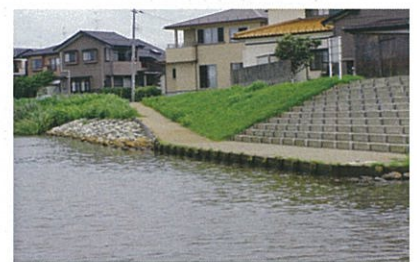
通船川護岸改良(階段・斜路)
