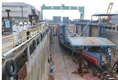
屋外ドック内船体組立作業中
